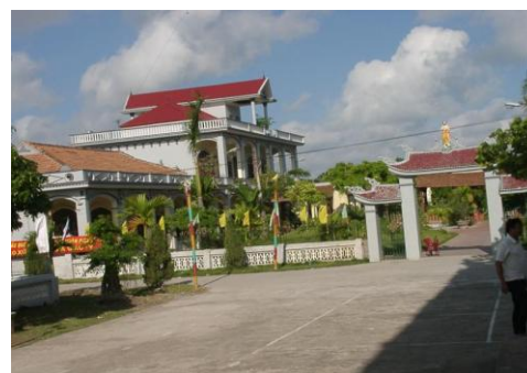
Nhà hưu dưỡng
